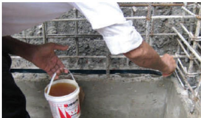
Ukuran grooving untuk Ultrachem® Waterstop SW 205 adalah 20 mm x 3 mm, dan Ultrachem® Waterstop SW 210 adalah 20 mm x 5 mm. Untuk area harus bersih dari debu, minyak, dll sebelum pemasangan.
